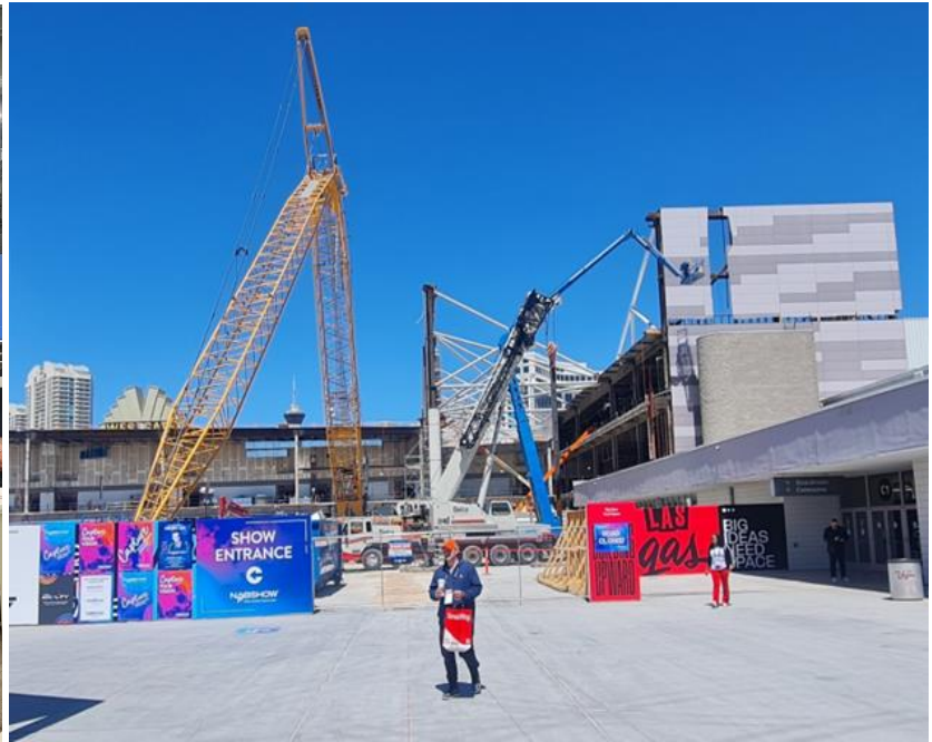
Grossbaustelle beim LVCC , jedes Jahr wird eine Halle erneuert.
