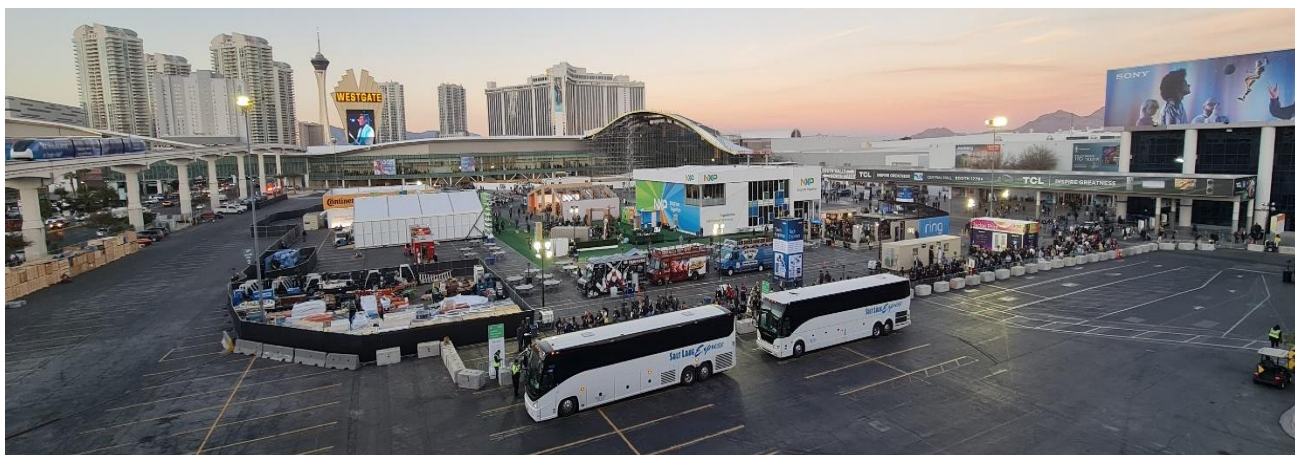
Das LVCC Vorgelände ist immer noch grosse Baustelle, aber deutlich verbesserte TechExpress-Verkehrsführung (Zwischen LVCC und Venetian). Alle Hotellinien nun vor der ESTHALLE
